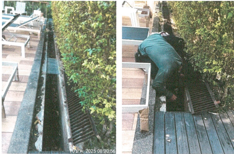
รูปภาพที่ 2.7 การขูดลอกตะกอน
